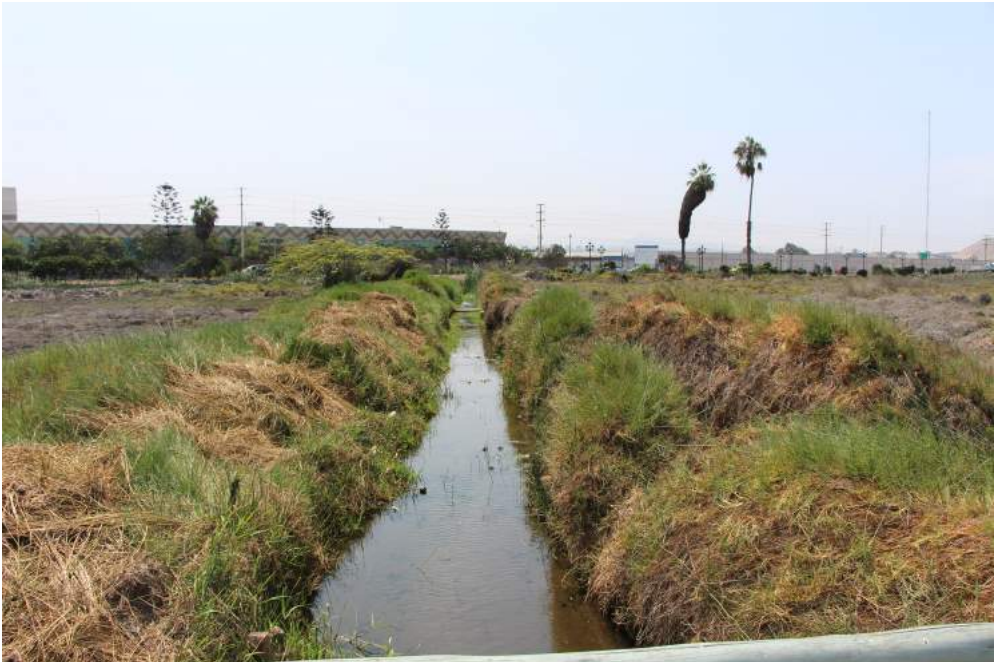
Fig. 16. Canales de drenaje que atraviesan los pantanos.
